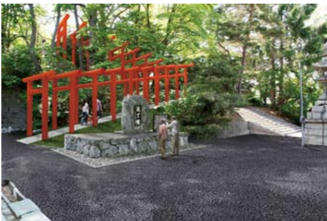
▲社務所前から社殿方向に緩やかに上がるスロープを新設
